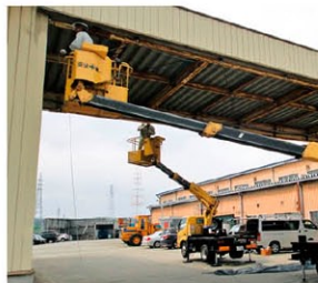
倉庫出入口ゲート 底部
