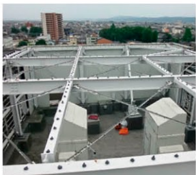
テナントビル 屋上部
