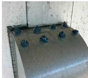
工場 換気フード部
